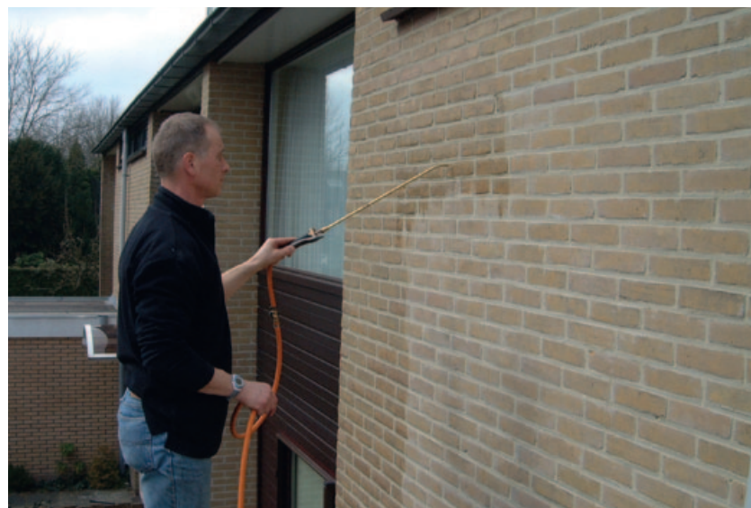
◀ Bij het impregneren wordt de vloeistof aangebracht door middel van de zogenoemde vloeimethode; onder lage druk het impregneermiddel verspuiten op het oppervlak.
