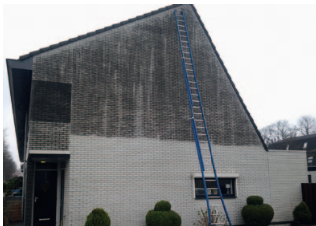
▲ Het resultaat is soms verbluffend. De bovenzijde is nog onbehandeld, terwijl de onderzijde is gereinigd met hogedruk en heet water.
