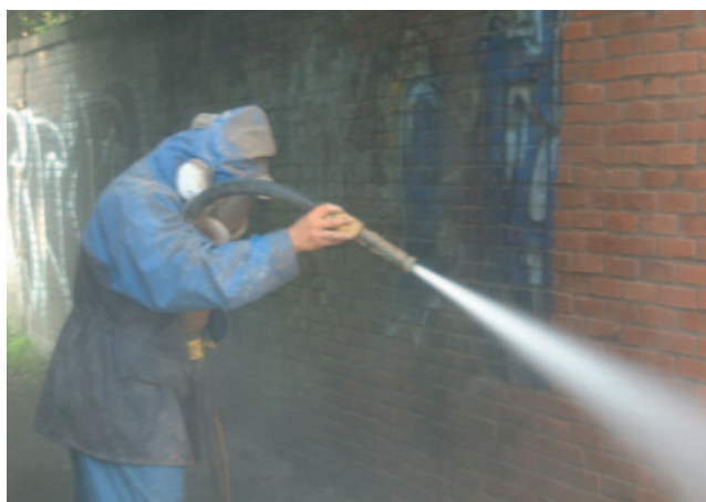
▲ Stoomreiniging, waarbij heet water onder hoge druk tegen de steen wordt gespoten.
