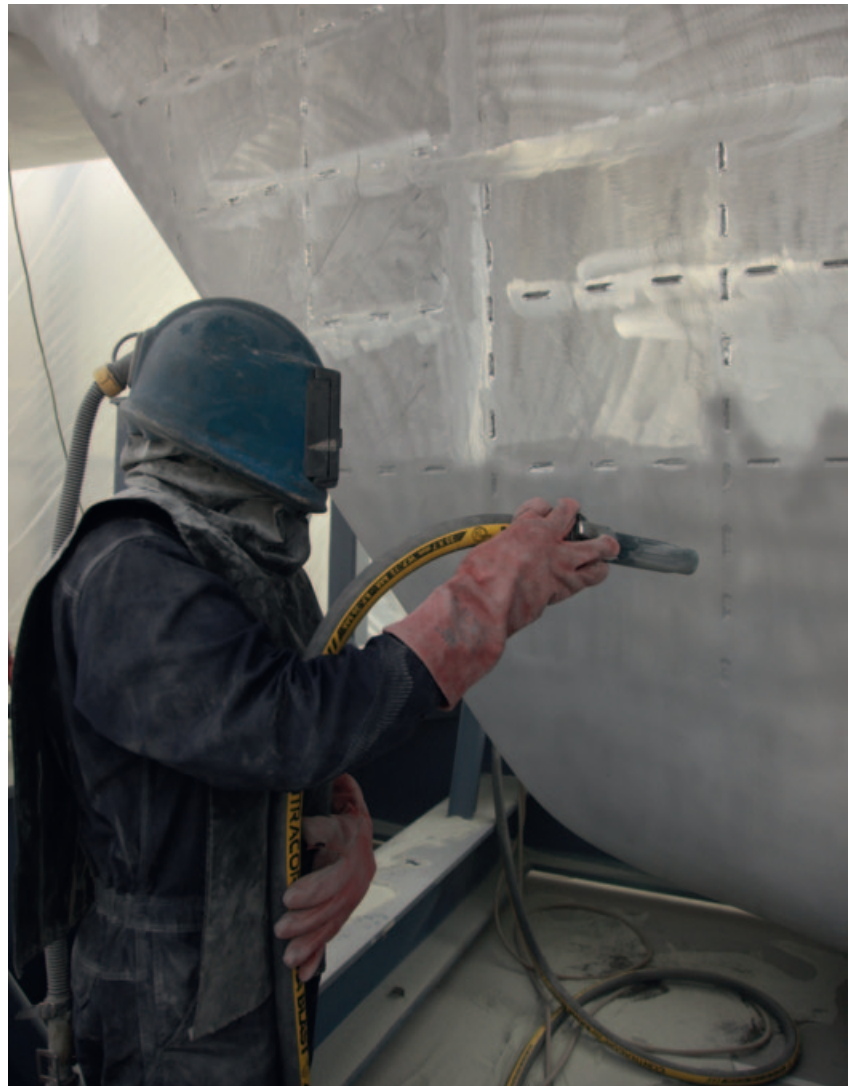
▲ Stralen is de meest ingrijpende vorm van reiniging. Hiervoor wordt vaak het mineraal olivinezand gebruikt.
